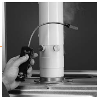
Локализация утечек дымовых газов с помощью прибора testo 317
