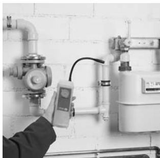
Обнаружение утечки газа вместе с testo 316
