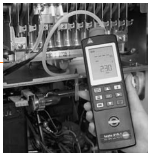
Испытание на герметичность с помощью testo 312-1/2
