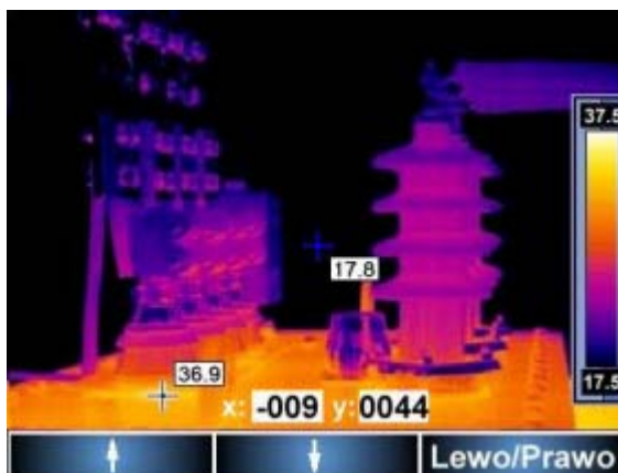
Рисунок 12. Установка новой точки постоянного отсчета температуры по вертикали
